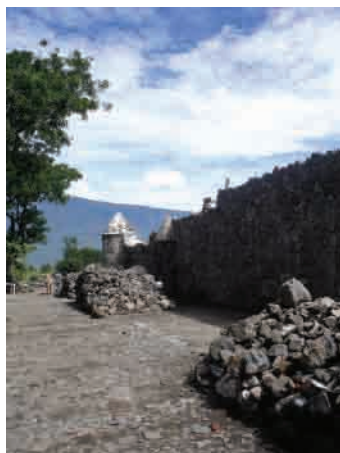
❏ 45 Detalles del muro derruido
