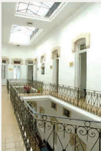
96 Pasillo con escaleras
