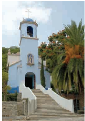
📍 122 Fachada del templo con escalera
