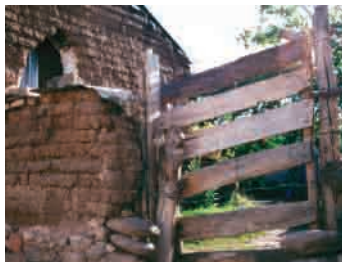
📍 214 Muro de adobe con puerta de madera
