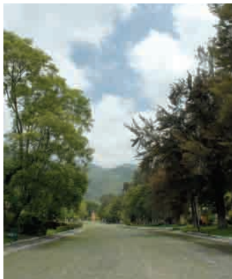
142 Otra vista de la carretera
