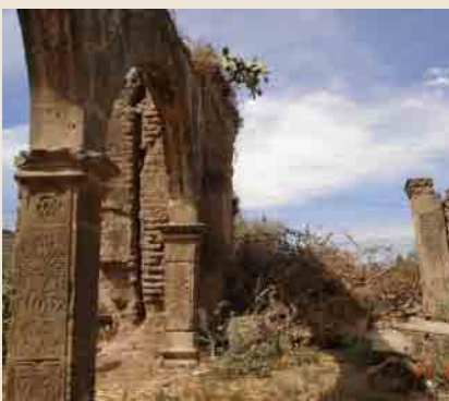
62 Restos de la nave central de la capilla de indios de San Sebastián.
