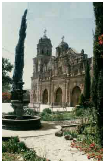
❏ 71 Vista del recinto atrial, en la capilla de indios de Santa Cruz de las Flores.
