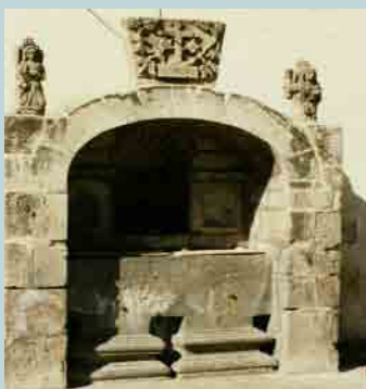
📷 77 Vista del depósito de agua del edificio de la Cofradía, anexo al Hospitalito.
