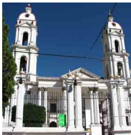
80 Vista desde el atrio de la fachada neoclásica de la iglesia de San Antonio de Tlajomulco.
