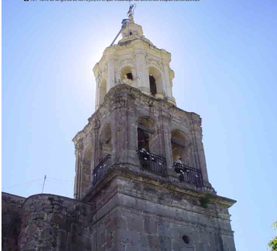
151 Torre de la iglesia de los Reyes, en el que visualizan las diferentes etapas constructivas.
