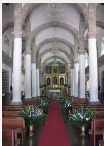
150 Vista de la nave central de la iglesia de los Reyes, con los arcos formeros y arcos fajones, con gran ingreso de luz a pesar de tener el mismo nivel las tres naves.
