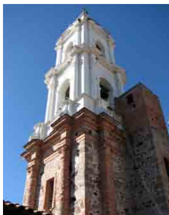
81 Vista desde el convento a la torre neoclásica de la iglesia de San Antonio, destacando la manufactura del aparejo y calidad del ladrillo, tradición de buena calidad en la zona.
